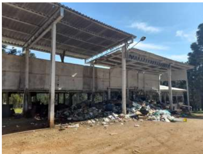
Figura 15 - Barracão de triagem
