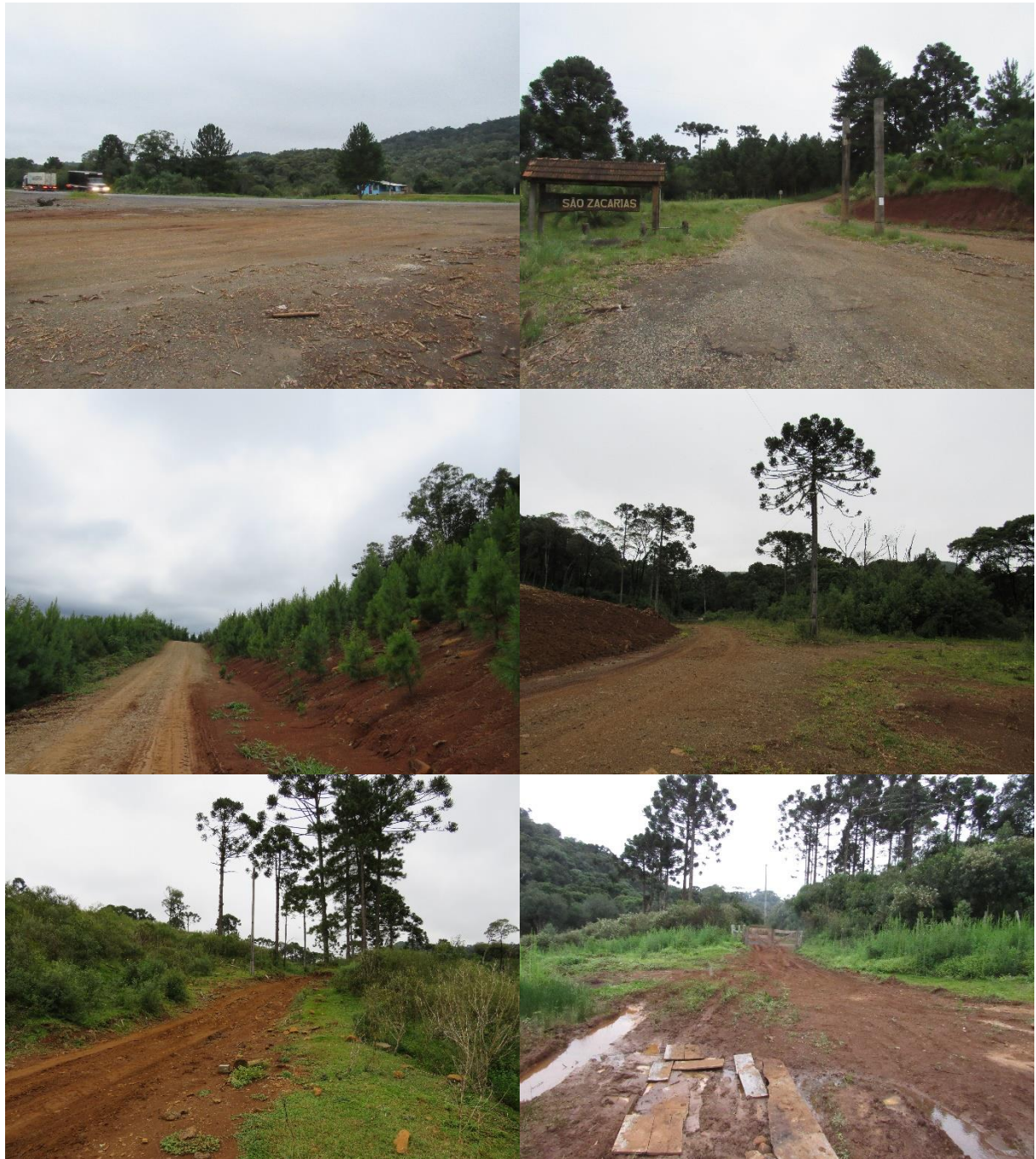
Figura 3-25: Visão geral de trechos da estrada de acesso principal a PNM.
