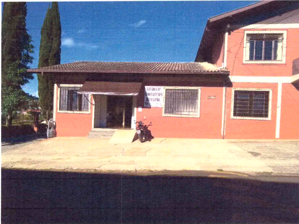
Figura 01 – Fachada do Imóvel
