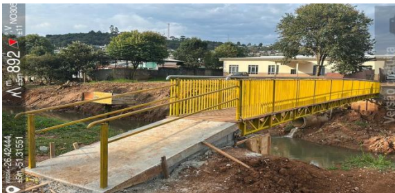
Passarela no final da rua Arlindo Lammel, aos fundos da rodoviária
